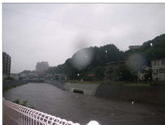
放水施設(平成22年の台風時)
