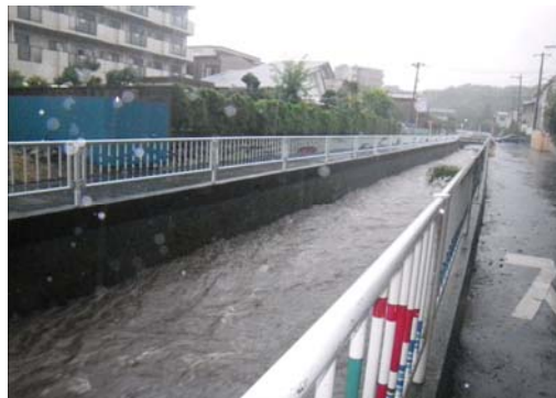
瑞光橋下流付近(平成22年の台風時)
