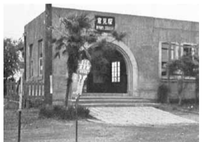
倉見駅の駅舎 (1963年)
