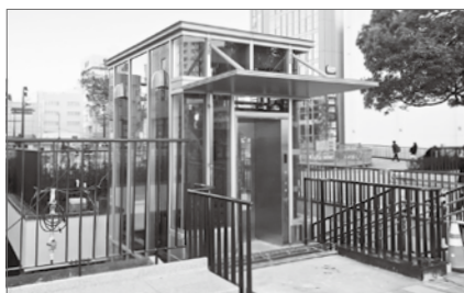
バスロータリー中央エレベーター
