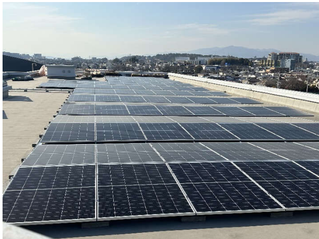
第一中学校屋上
