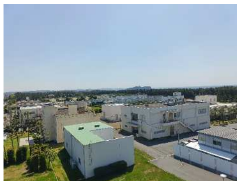
【辻堂浄化センター】
