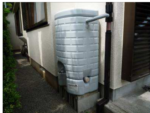
【雨水貯留槽設置例】
