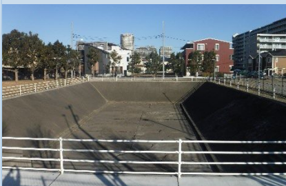
オープン式調整池
