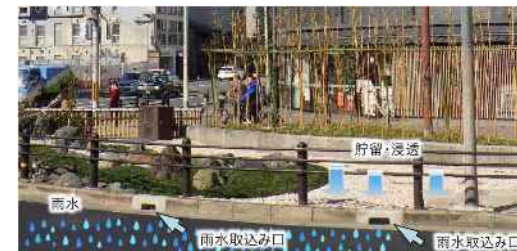
グリーンインフラを活用した雨水対策例（雨庭） ※国土交通省資料より
