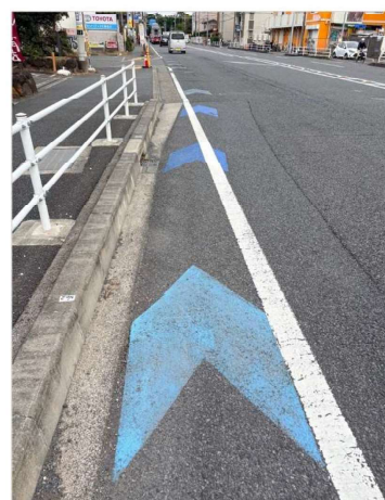
図4-14 外側線と矢羽根が交差する場合の整備
