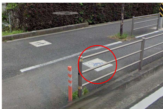
図 5-8 自転車ピクトグラム (600mm×600mm)
