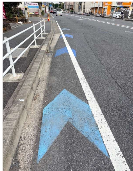
図 4-14 車道外側線と矢羽根が交差する場合の整備
