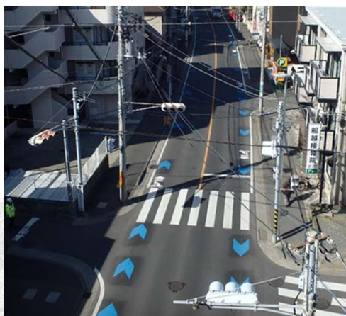
自転車通行空間整備の様子 (市道藤沢村岡線)
