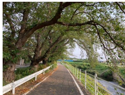
境川サイクリングロード 藤沢大和自転車道
