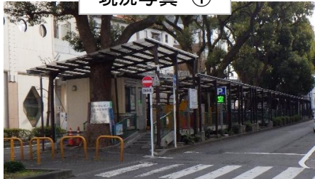
現況写真 ①
