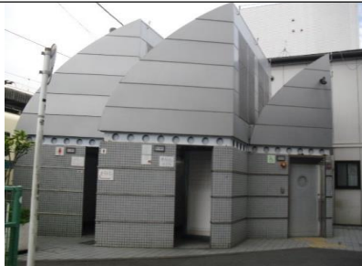
現況写真(既存公衆トイレ)
