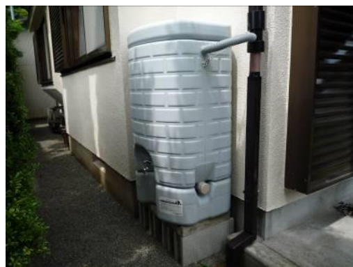
【雨水貯留槽設置例】
