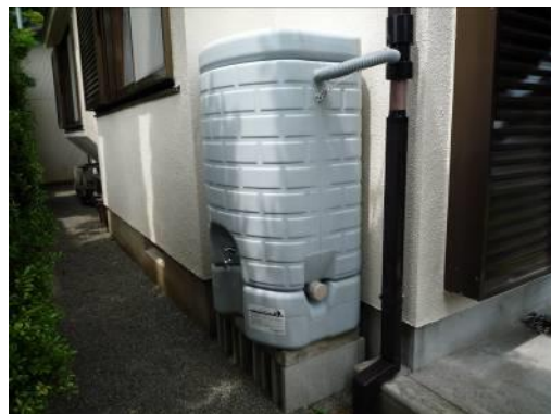
【雨水貯留槽設置例】
