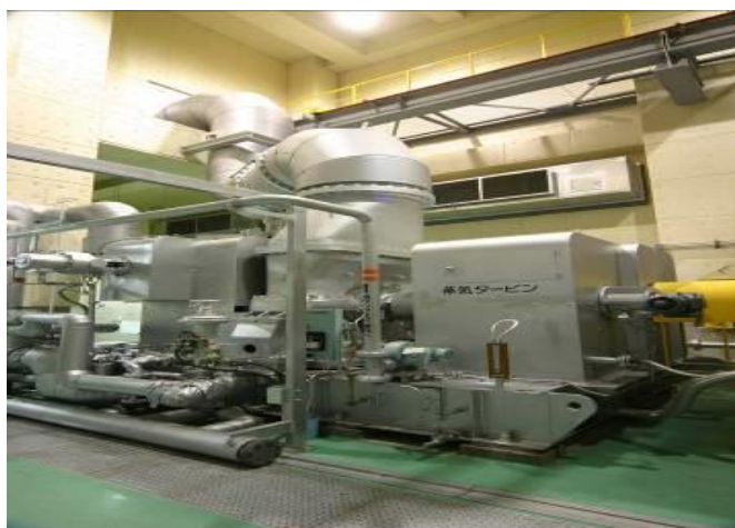
【蒸気タービン&発電機】
