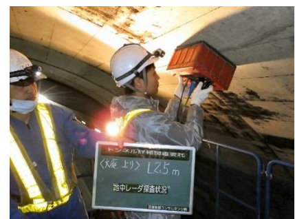
覆工背面空洞探査状況
