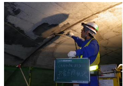
近接目視・打音検査状況
