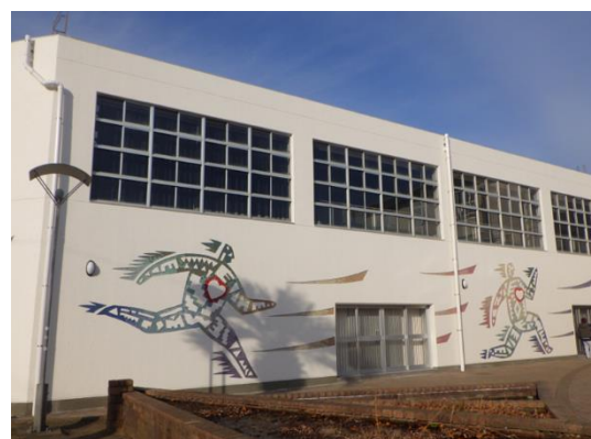
外壁改修後の屋内運動場
