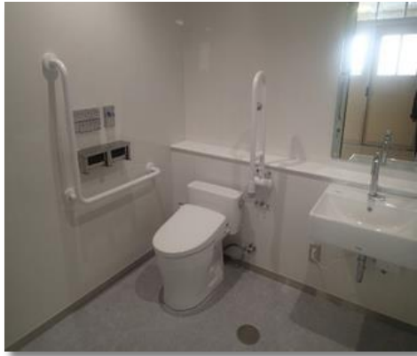
改修によってリニューアルされたトイレ (多目的トイレ)
