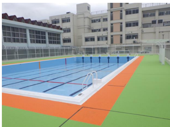
岳体塗装等改修工事後のプール
