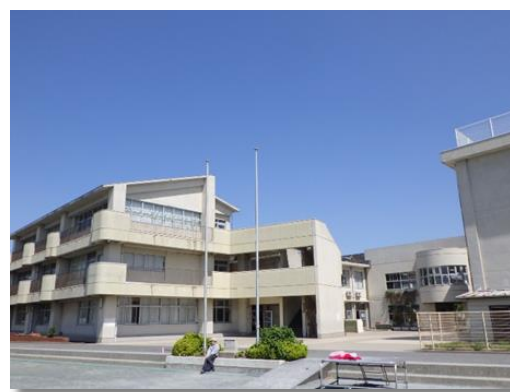
鶴洋小学校既存校舍棟
