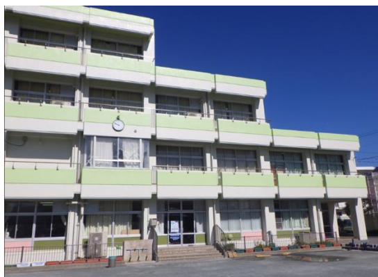
外壁改修工事後の校舎棟
