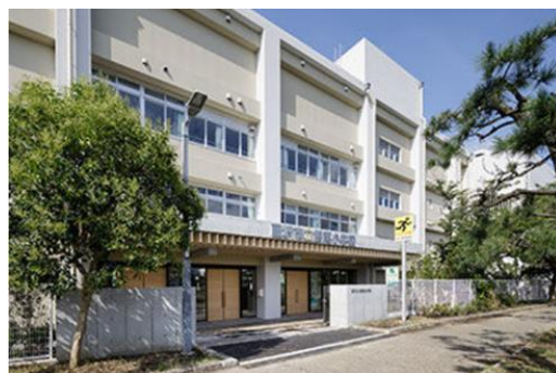
鶴南小学校新校舎正門
