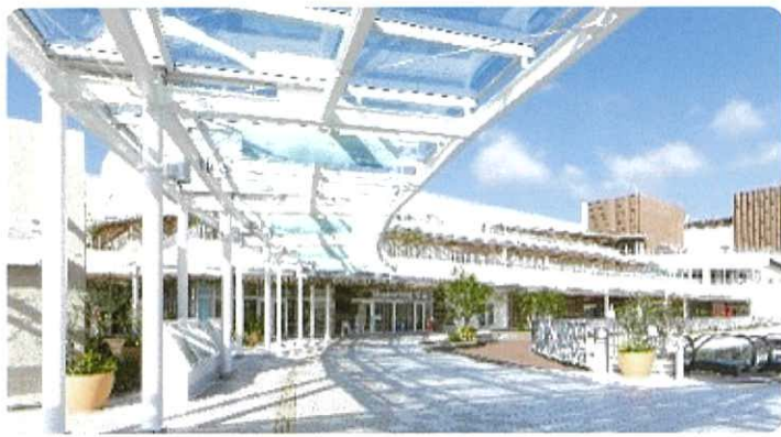
Terrace Mall 湘南 〒251-0041 藤沢市辻堂神台 1-3-1
