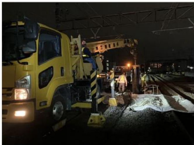
電柱基礎杭打設状況
