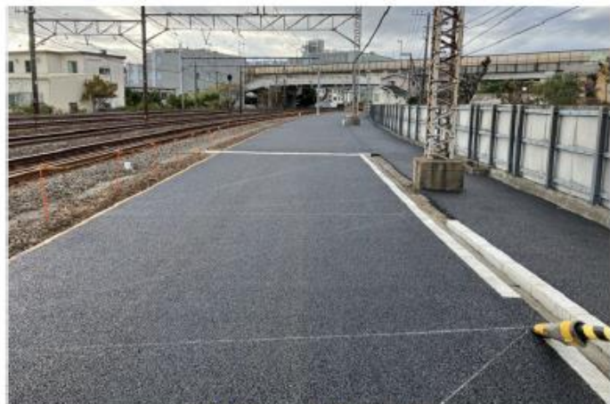
保線ヤード整備
