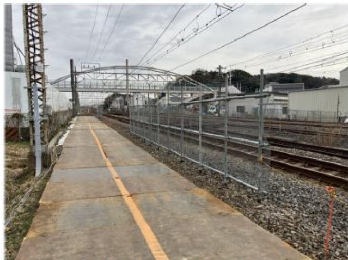
鉄板敷設・線路防護網
