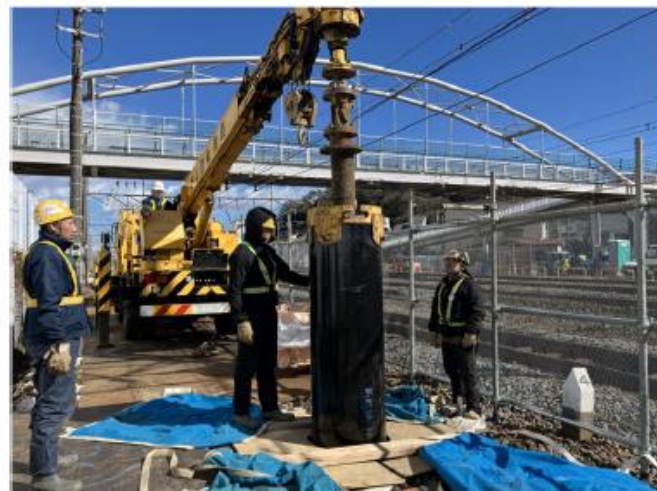
電柱基礎杭打設状況
