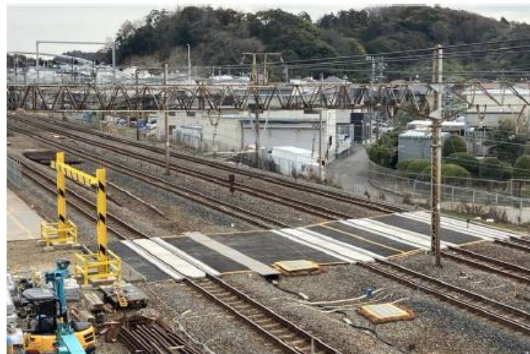
線路覆工・空頭支障防護
