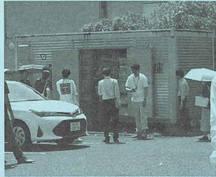
多摩大学での防災倉庫内確認の様子
