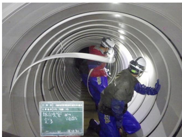
老朽化対策工事
