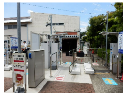
⑥ 自転車等駐車場ゲート部分
