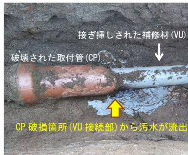
図-6 破壊された取付管(地点C)
