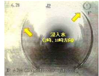
図-6. 管内カメラ状況写真
