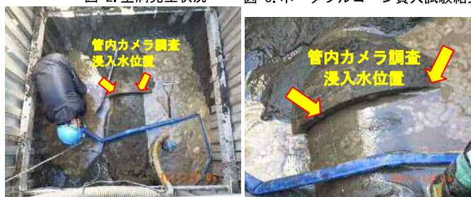
図-4. 開削状況写真
