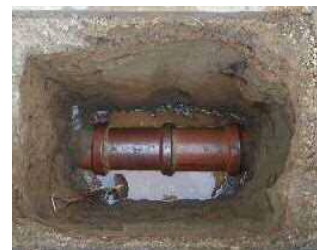
図-10. 下水道管敷設状況写真
