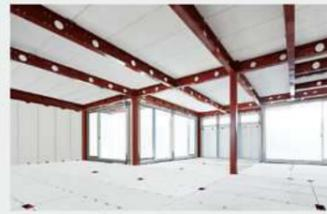
重量鉄骨を剛接合した強靭な構造躯体。
