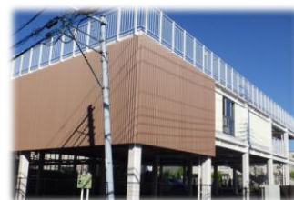
(片瀬海岸3丁目津波避難タワー)
