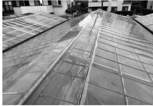
ビニールハウス被覆資材の張り替え
