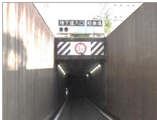
藤沢駅北側車地下道
