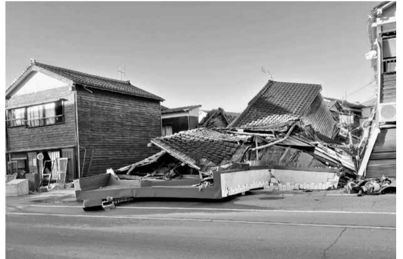
能登半島地震の被害の様子
