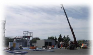
(7) 河川氾濫防止訓練 (1 t土のう積み)
