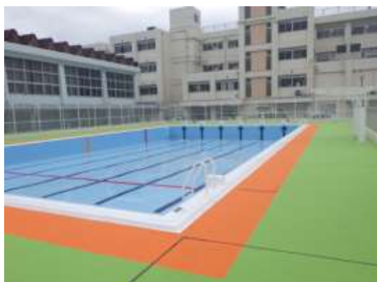
缶体塗装等改修工事後のプール
