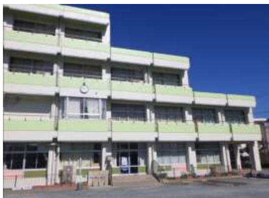
外壁改修工事後の校舎棟
