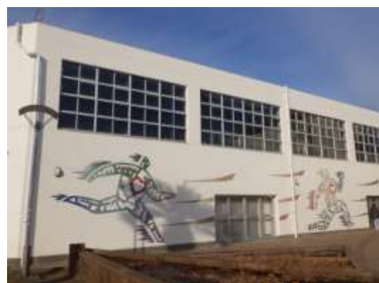
外壁改修後の屋内運動場
