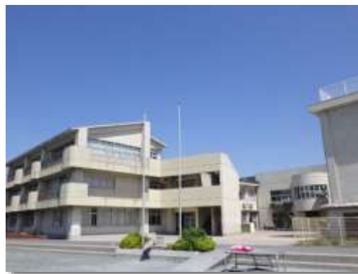
鵜洋小学校既存校舎棟
