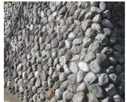
自然石積み擁壁
