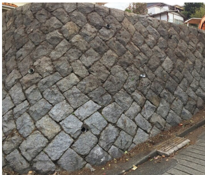
間知石積み擁壁
