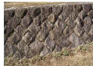
間知石積み擁壁・雑割石積み擁壁
