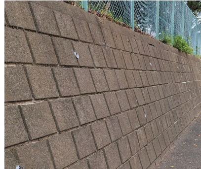
間知ブロック積み擁壁（布積み）
