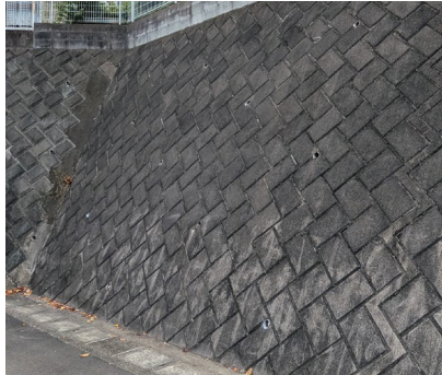
間知ブロック積み擁壁（谷積み）
