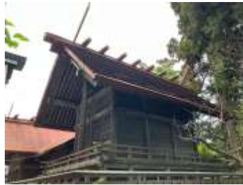
本殿北側外観
