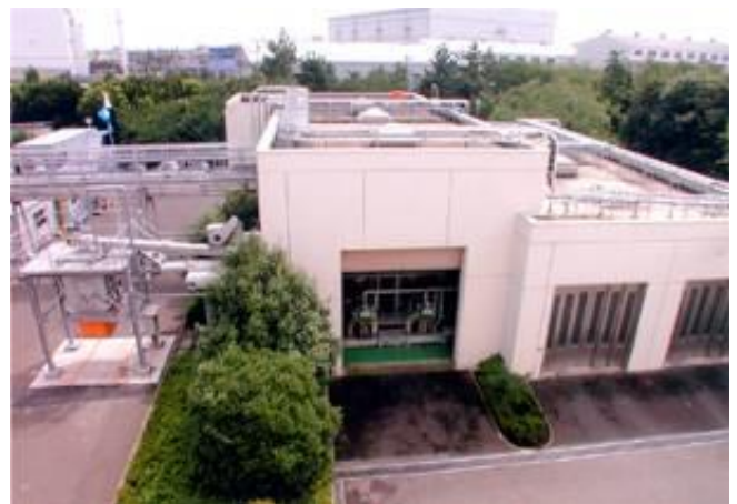
受入棟（前処理施設）
