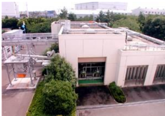
受入棟（前処理施設）
