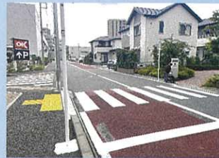
設置された横断歩道
