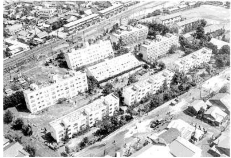
液状化による鉄筋コンクリートアパートの倒壊 総理府
