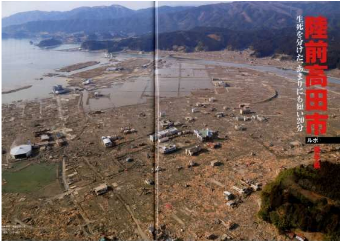
住宅の被害 津波による流失
