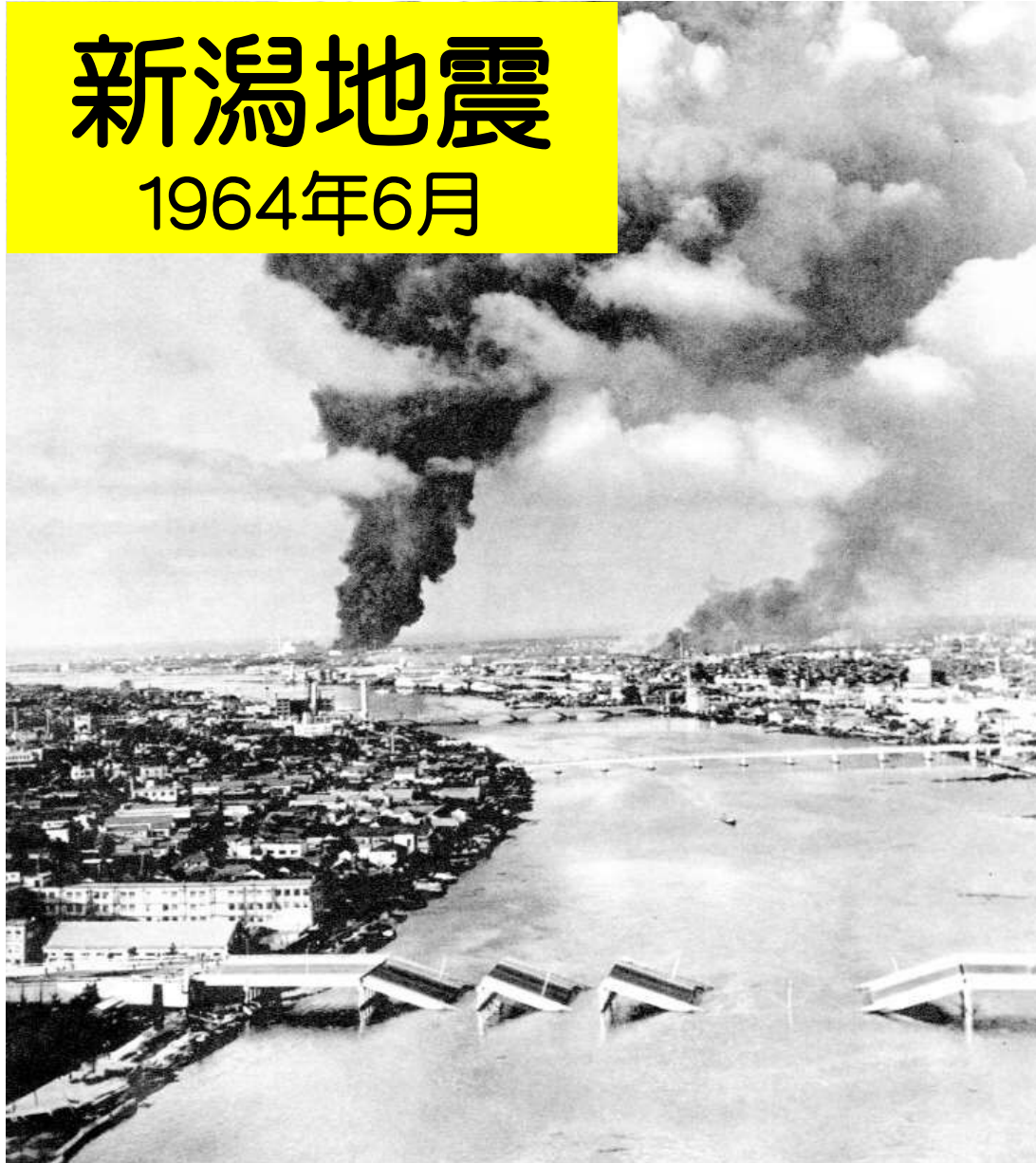
石油タンクの炎上、単純桁橋の落下 新潟日報社
