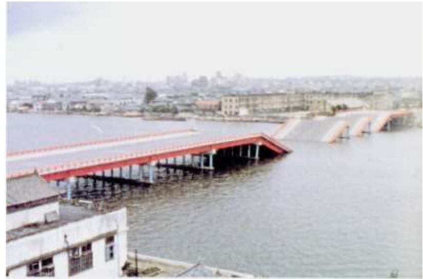
単純桁橋の落下 伯野
