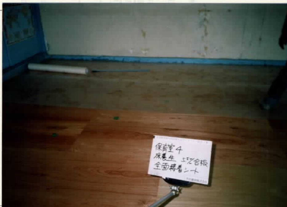
写真2 床全面接着シート貼り
