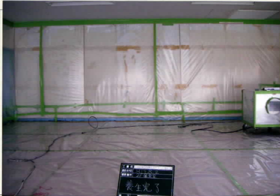
写真4 壁プラスチックシート張り
