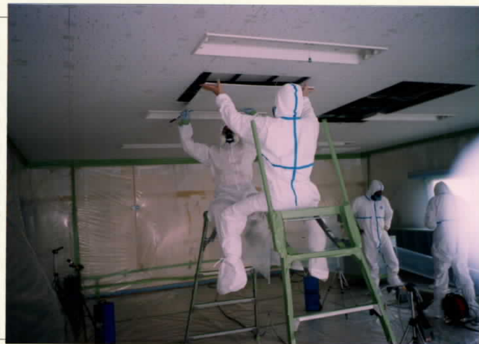
写真5 天井ボード取り外し
