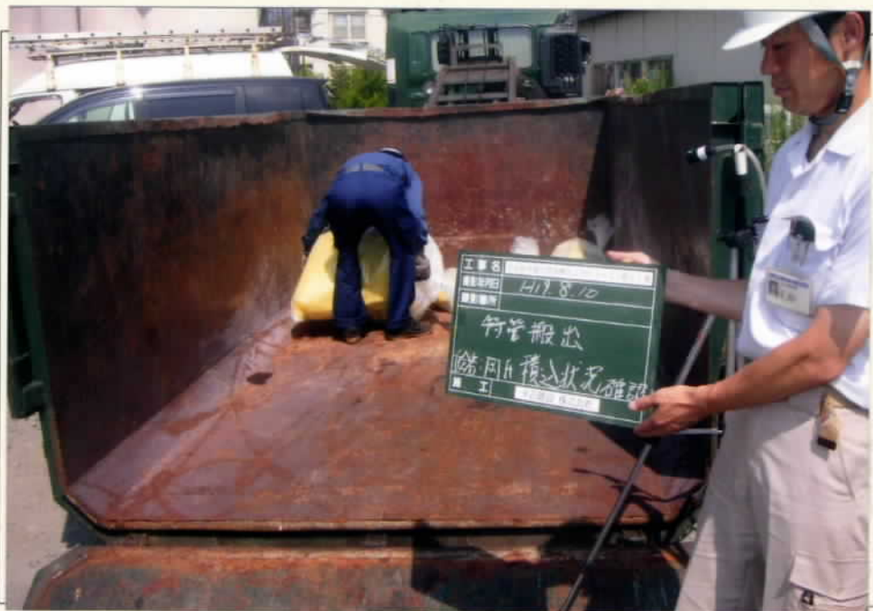
写真8 アスベスト廃材の搬出
