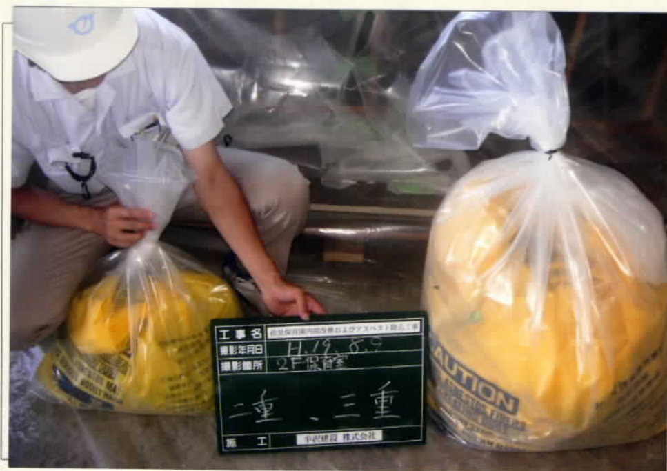
写真7 アスベスト廃材の三重袋詰め
