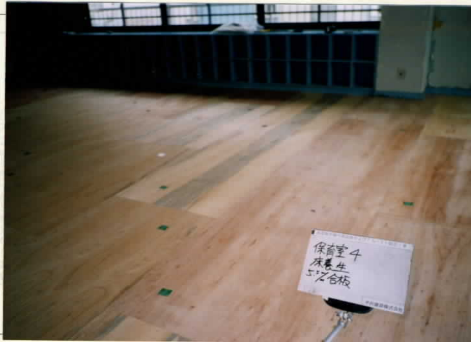
写真1 床ベニヤ板敷き
