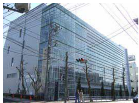
（藤沢市保健所建物外観）
