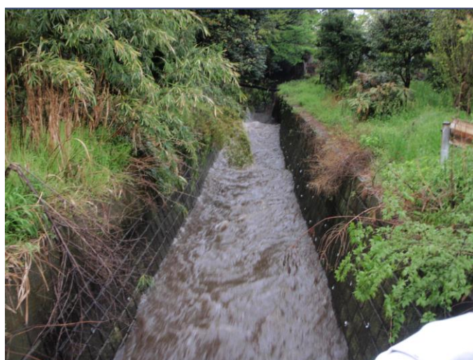
稲荷山橋上流付近(平成22年大雨注意報発令時)
