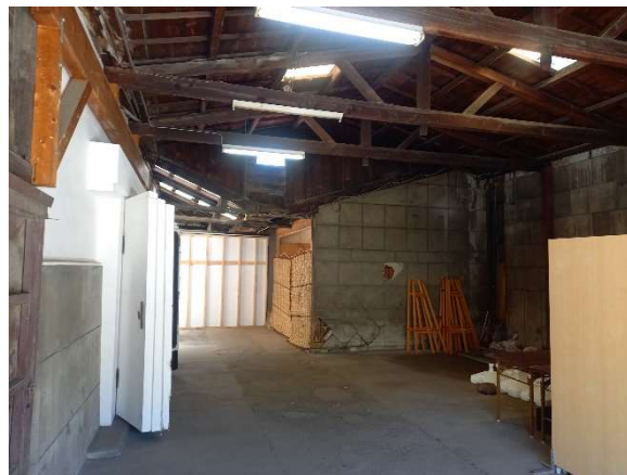
①増築倉庫
