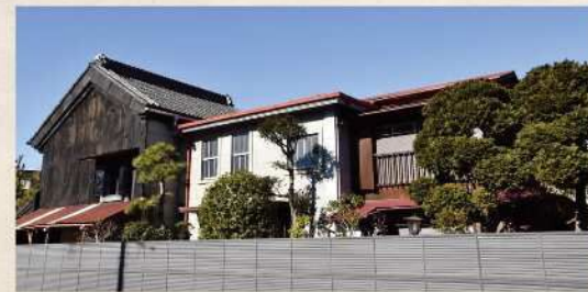
主屋 東側外観
