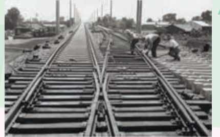
新東海道線工事 ※
