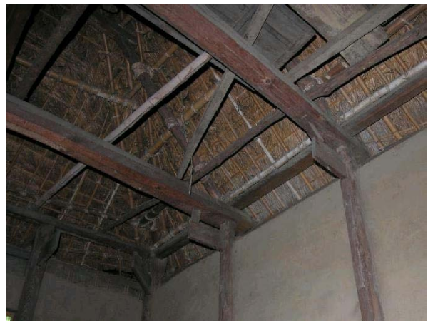
東側土間物置の屋根裏
