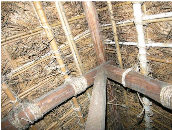
銅板屋根の内部に保存されている草屋根
