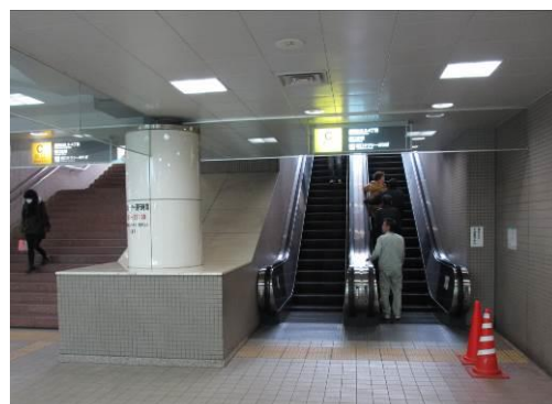
地下道出入り口でのエスカレーター設置によるユニバーサルデザインのイメージ（湘南台駅地下道）
